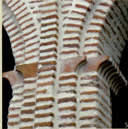
[ ] 1.- CORNISA de Navarredonda (ladrillos cortados en nacela y friso de esquinitas). 2.- CORNISA de Camarma (modillones de ladrillos escalonados). 3.- ALFIZ de Carabanchel (frisos de ladrillos a sardinel y en esquinita). 4.- ARRANQUE de arquería en Prádena (ladrillos cortados en nacela). 5.- CUBIERTA de Cubas (armadura ochavada de par y nudillo, con dobles tirantes y almizate decorado con lazo). 6.- CUBIERTA de Montejó (mismo tipo de armadura, con lacería en madera de roble con mocárabes).
