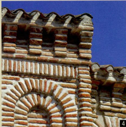
[ ] 1.- CORNISA de Navarredonda (ladrillos cortados en nacela y friso de esquinitas). 2.- CORNISA de Camarma (modillones de ladrillos escalonados). 3.- ALFIZ de Carabanchel (frisos de ladrillos a sardinel y en esquinita). 4.- ARRANQUE de arquería en Prádena (ladrillos cortados en nacela). 5.- CUBIERTA de Cubas (armadura ochavada de par y nudillo, con dobles tirantes y almizate decorado con lazo). 6.- CUBIERTA de Montejó (mismo tipo de armadura, con lacería en madera de roble con mocárabes).
